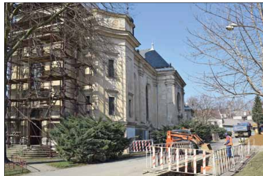
Foto 1: Pohled na nový výkop kanalizace v místech, kde byly nalezeny narušené kosterní pohřby, v pozadí je patrný farní kostel, od V (foto J. Vrána).
