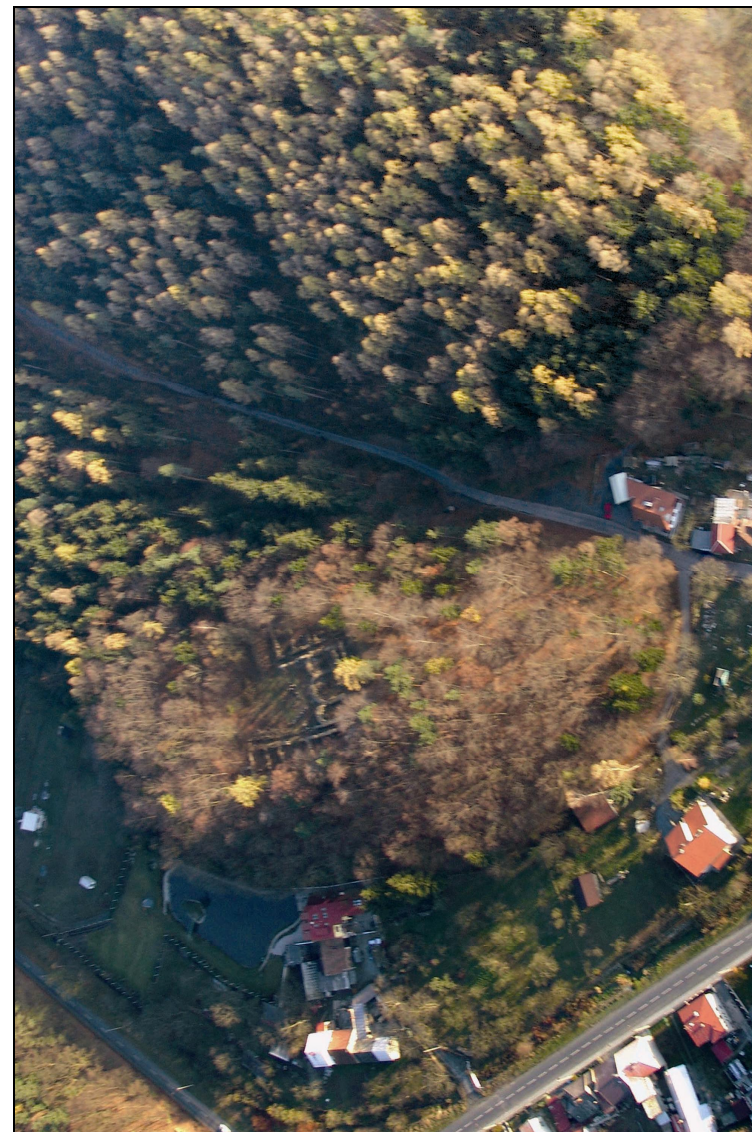
Obr. 3. Dolany, kartouza – letecký snímek lokality, zřetelně je vidět závěr kostela i boční kaple, velký ambit a mnišské cely, stav z roku 2005 (foto M. Kalábek).
